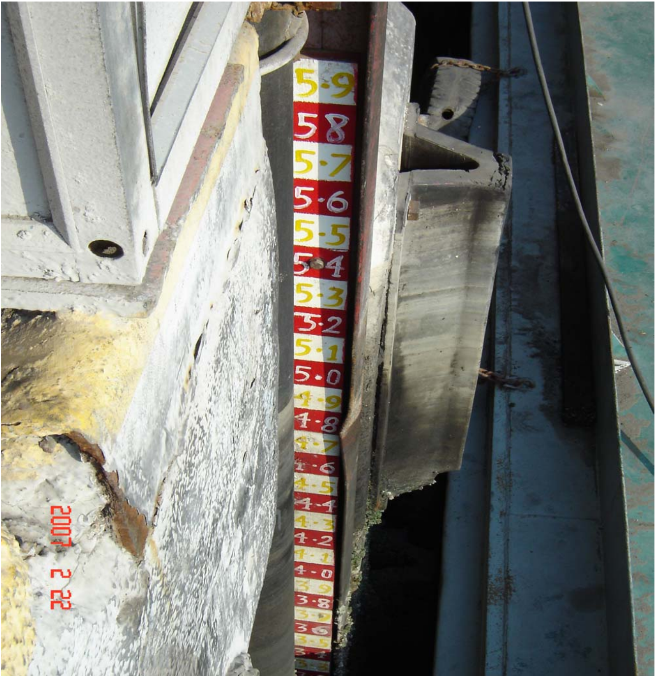
Fig. 6 Tide gauge pole
